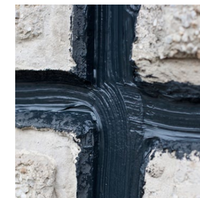
Precizní a čistý detail po vytvrzení.
