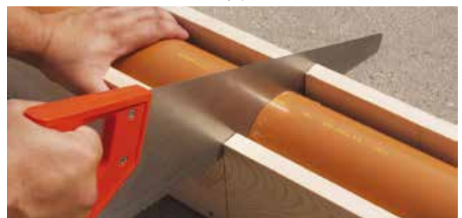
Obrázek 2 Zkracování trubky pilkou
