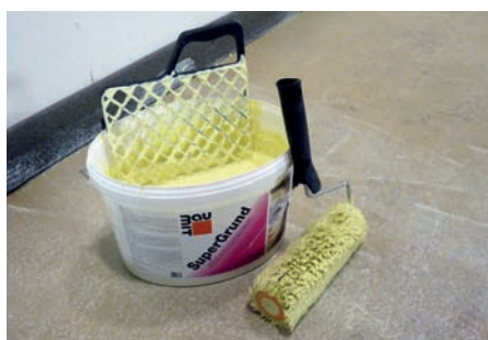
Nanesení systémového kontaktního můstku
