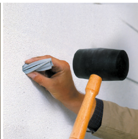
Hmoždinky určené na kotvení do pórobetonu zaručí spolehlivou funkci spoje.
