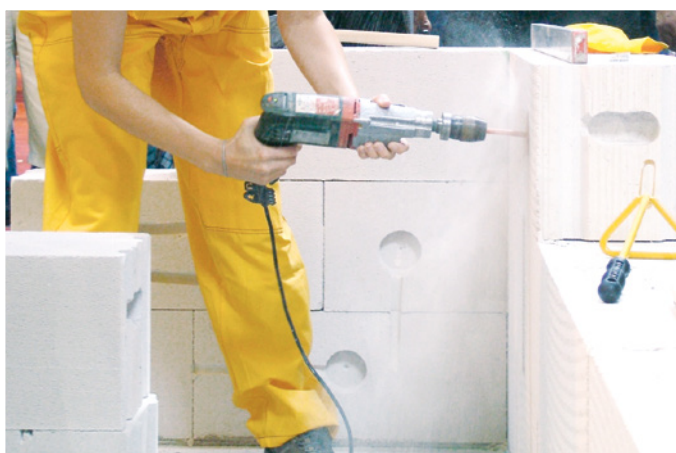
Vrtání do pórobetonu je jednoduché.
