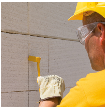
Vytváření drážek pomocí drážkovače představuje jednoduchý úkon.
