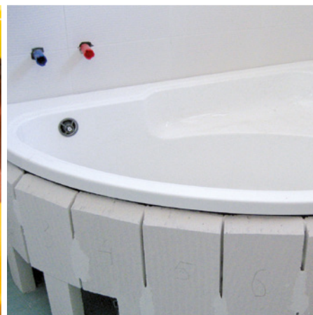
Obkládání vany s materiálem Ytong je bezproblémová záležitost.
